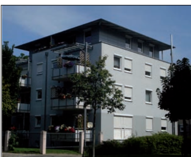
Deutlich zurückgesetztes Dachgeschoss
