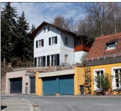
Niederlößnitz, Obere Bergstraße: Garagen in Farbigkeit der Hauptge- bäude, die Reihung ist problematisch
