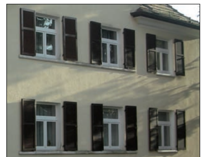
1920er/ 30er Jahre: Fenster mit Läden und dezentem Brüstungsgesims
