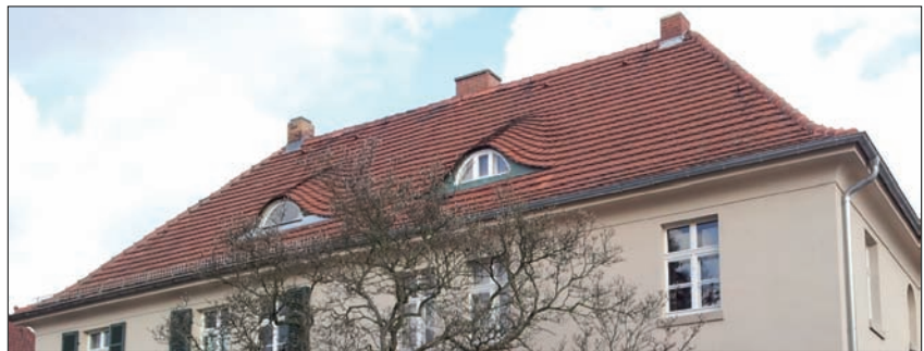
Walmdächer mit Biberschwanzdeckung finden sich oft bei Gebäuden der 1920er und 1930er Jahre
