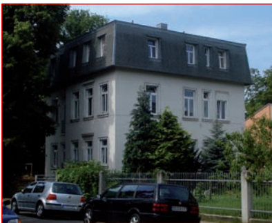
Das Dach wirkt dem Gebäude übergestülpt und sehr schwer.
