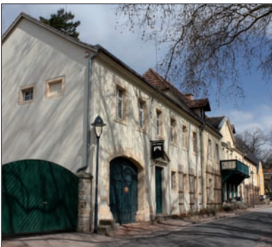
Winzerhaus: Fassadengrundton ist ein gebrochenes Weiß, grüne Holzelemente sind abgesetzt
