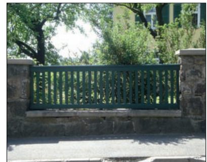
Holzzaun mit Deckbrett zwischen Natursteinpfeilern
