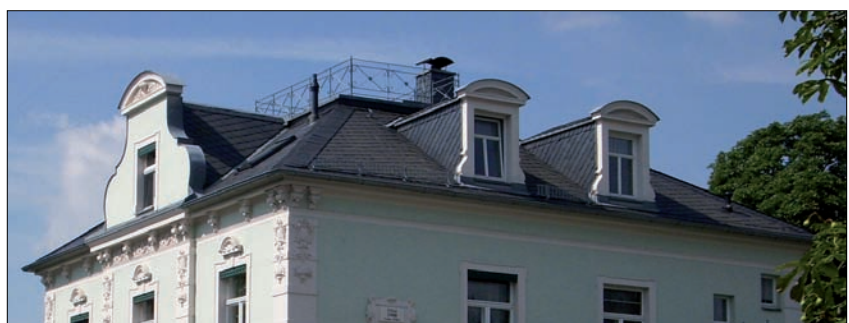
Durchgängiges Traufgesims definiert einen klaren Abschluss für das Dachgeschoss. Ziergiebel (über dem Mittelrisalit) und Lukarnen liegen darüber.
