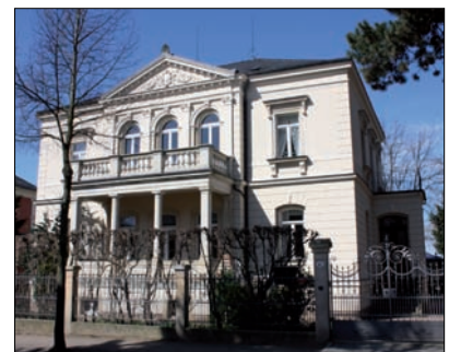
Auf Stützen ruhende Plattform (Söller) im Obergeschoss
