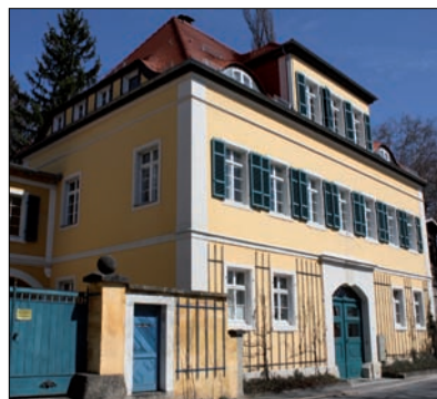
Niederlößnitz, Obere Bergstraße 30: Haus Minckwitz, 1713/14 in barockem Stil erbautes Herrenhaus
