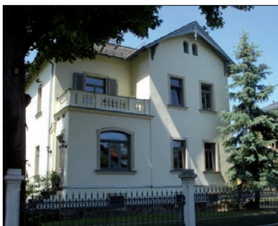
Auf Mauern ruhender Söller im Obergeschoss
