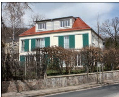
Neubau mit geneigtem Satteldach und roter Eindeckung
