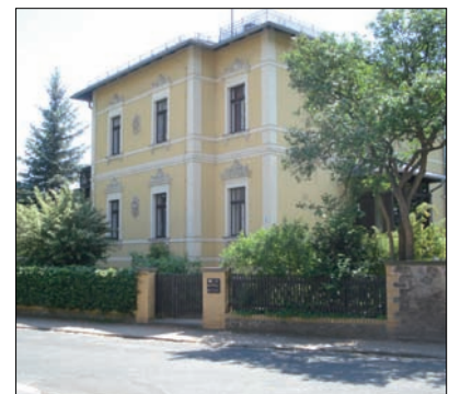
Oberlößnitz, Heinrich-Zille-Str. 1: Bäume und Sträucher rahmen das Gebäude
