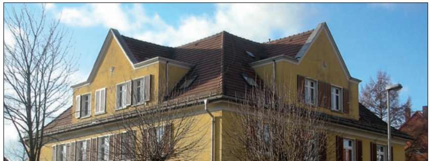
Zwerggiebeldächer im Gebiet sind eine Besonderheit der Reformarchitektur aus den 1920er und 30er Jahren.
