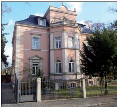
Oberlößnitz, Hauptstraße 53: Villa mit Standerker und Terrasse, erbaut 1896
