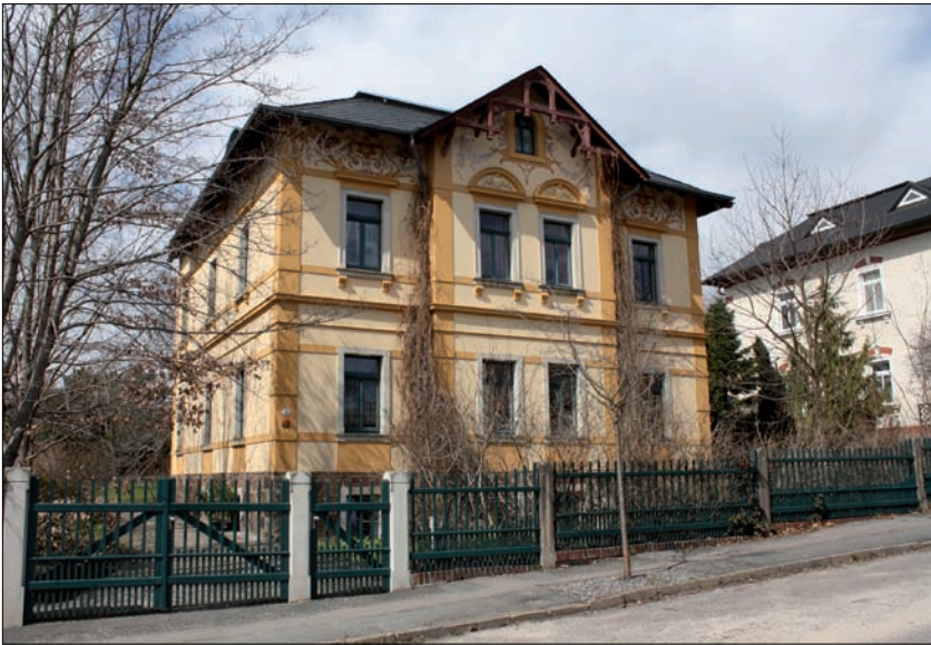
Niederlöbnitz, Humboldtstraße 5: Farbgestaltung mit intensiveren Tönen; heller Fassadengrundton, dunkler abgesetzte Verzierungen, Fenster und Zaun grün; Giebel und Drempel zieren Wandmalereien
