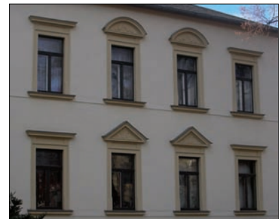
Villenfenster mit Verdachung über der Öffnung
