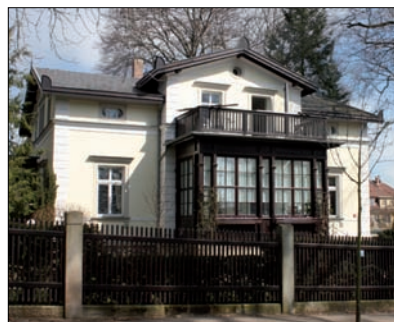
Hölzerne, verglaste Veranda (EG) mit Plattform (Söller) im OG
