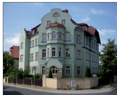
Erker betont die Schauffassade zur Ecke (Jugendstil)
