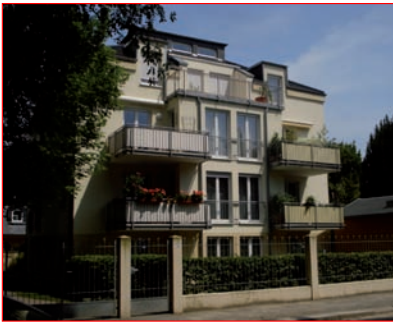
Balkone dominieren die Fassade (große Anzahl, massive Erscheinung)
