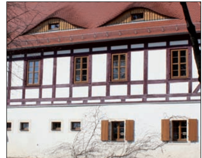
Ruhig gereimte Fenster im OG, kleine EG-Fenster zeigen einstigen Stall
